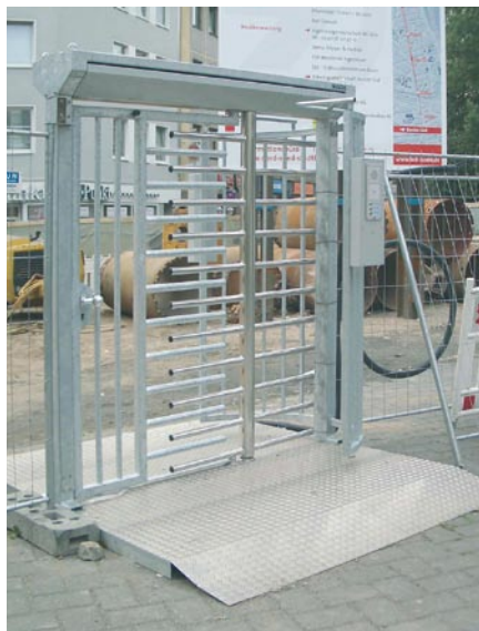
Solución móvil. Torniquete con puerta integrada, como cierre temporal de una obra
