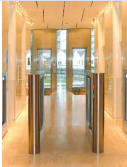
Control de acceso en las dos direcciones. Pasillo de vías múltiples y esclusas unipersonales Orthos
